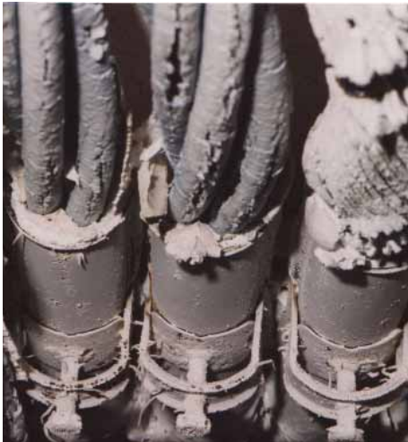
Verlegeart Bügelschelle mit Langwanne nach 90 Minuten Beflammung bei 1000°C
